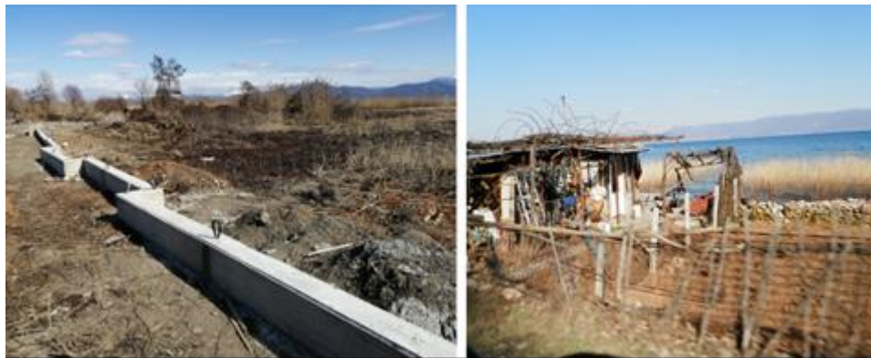
слика 26.Бетонски ѕид на појас Струга-Калиште и монтажна куќарка Радожда
