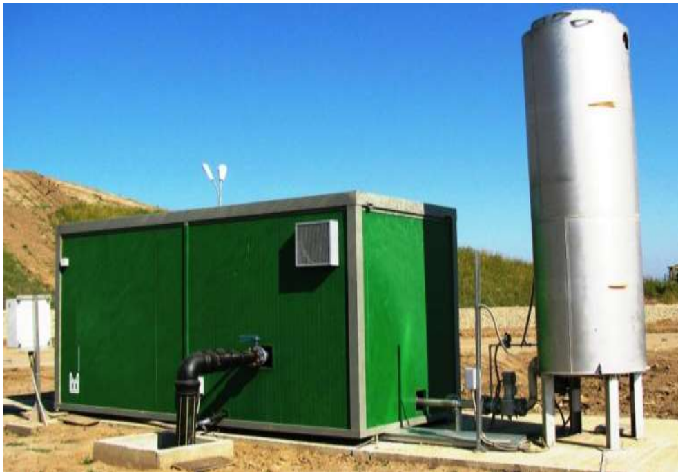
Слика 3-63: Пример на постројка за третман на гас на депонија
