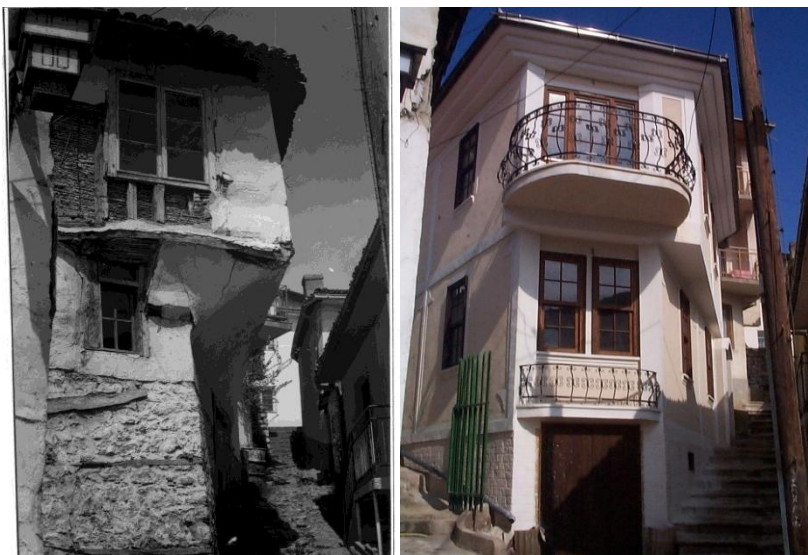
слика 5. пример на реконструкција / пред рушење и после изградба на нов објект.
