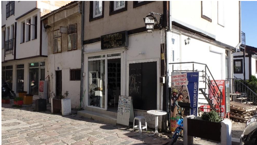
Фото (509) КП 15487, 15488, 16293 (три објекти)
